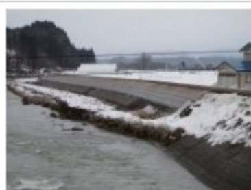
米代川河川災害復旧
