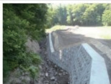
柏木森地区農業用施設災害復旧
