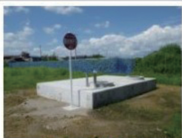
寺坂・防火水槽建設
