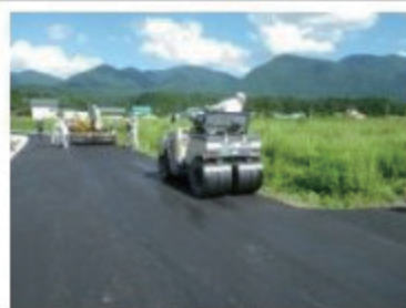
市道尾去沢線道路改良
