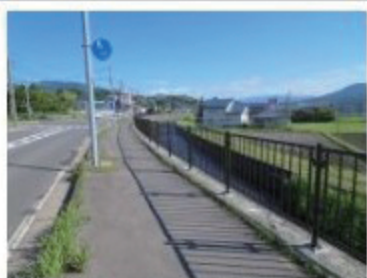
扇ノ間県単道路補修工事
