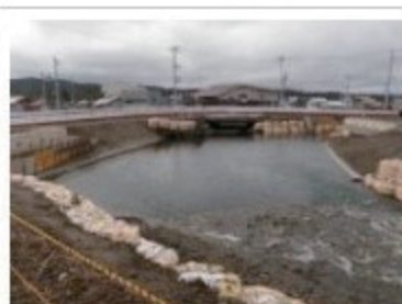
福士川・統合流域防災工事
