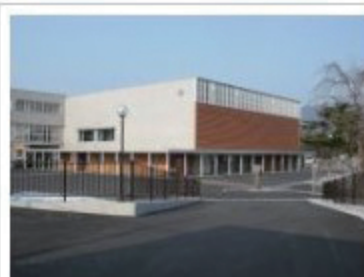
花輪小学校改築工事
