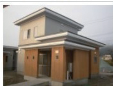
牛川原地区公営住宅
