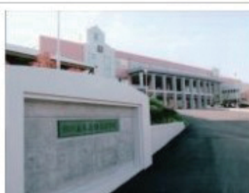
花輪高校学校校舎棟改築
