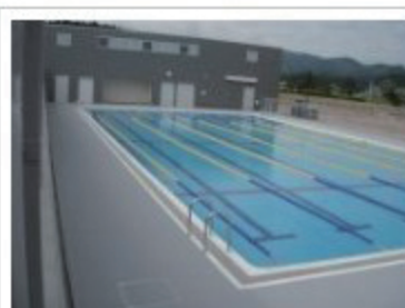
八幡平中学校改築プール建設
